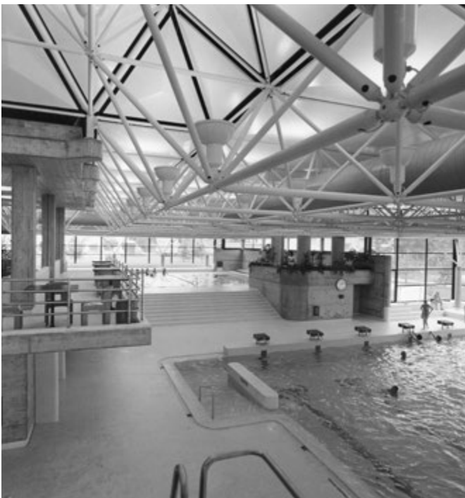
Mehrgeschossige Schwimmhalle, Foto: Peter Grünert, Datum unbekannt
