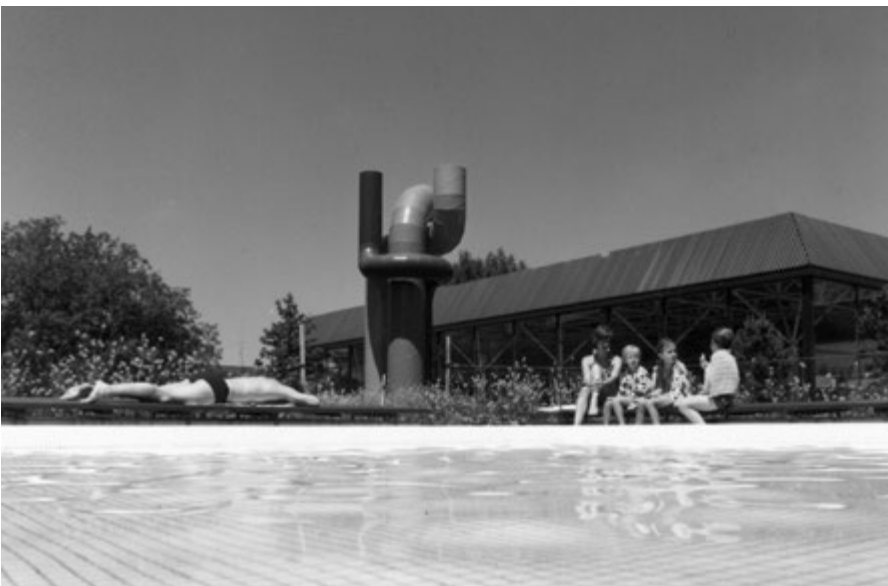
Aussenschwimmbecken mit skulpturalen Lüftungsrohren, Baugeschichtliches Archiv der Stadt Zürich, 1974
