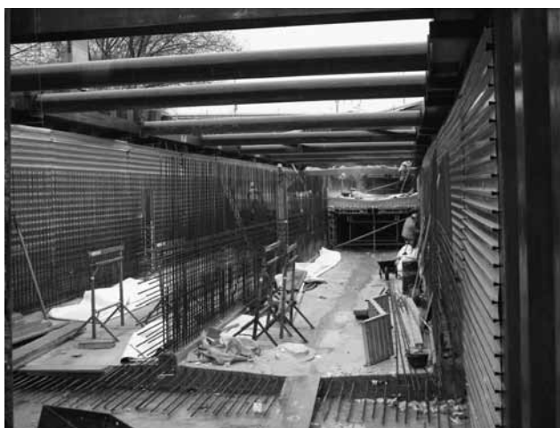
Der neue Abwasserkanal im Hardhof. (Bild: TAZ)
