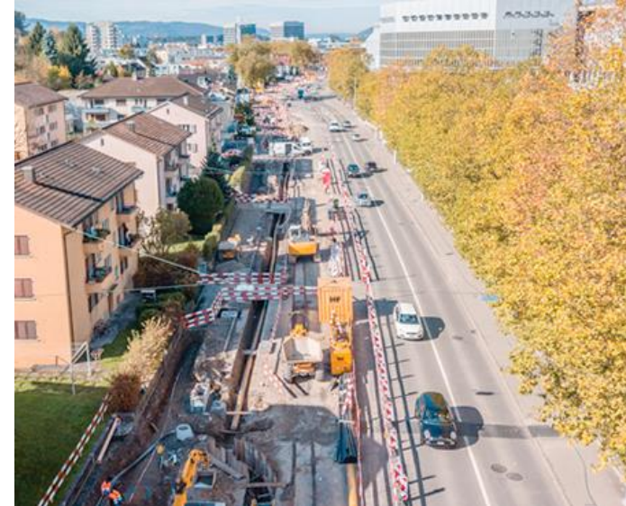
Baublauf-Konzept wie bei Limmattalbahn
